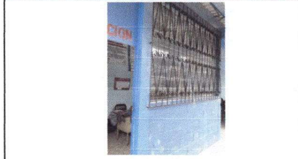
Foto 2: Sustrucción de balcones de metal
