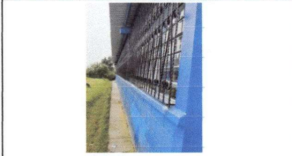
Foto 1: Sustrucción de balcones de metal
