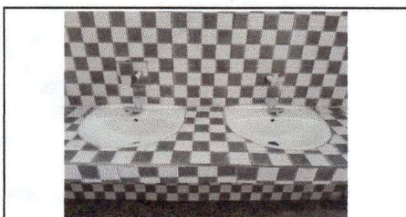
Foto 5: Sustrucción de lavamanos
